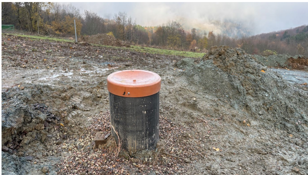
Obrázek 14: Dočasné zhlaví vrtu HEV-1
