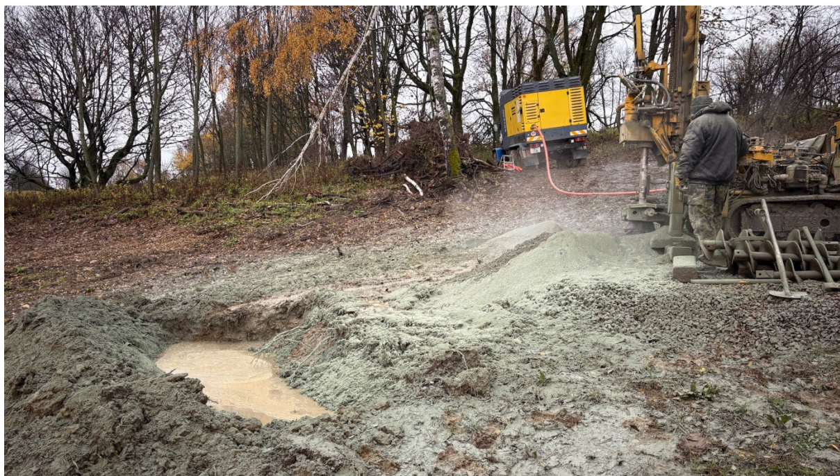
Obrázek 10: Odsazení odvrtného materiálu v kalové jámce
